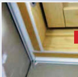
**1** Coller le profilé sur le châssis de la porte ou de la fenêtre.
