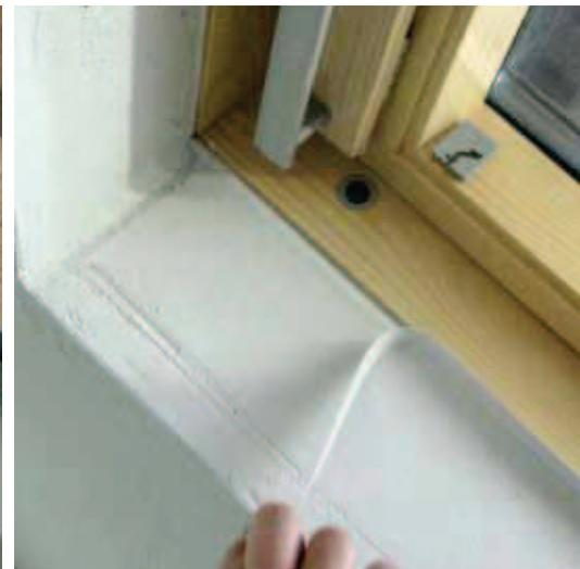
**3** Joint de dilatation empêchant les fissures entre l'enduit et le châssis de la fenêtre (plus besoin de silicone)
