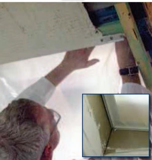
**1** Protection de la fenêtre et du châssis contre les salissures pendant la pose de l'enduit
